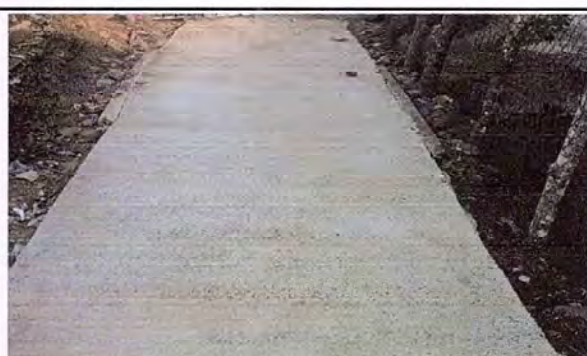
Foto 4: Terminación de pavimentación de la entrada principal de la EORM Caserio Chioyal.
