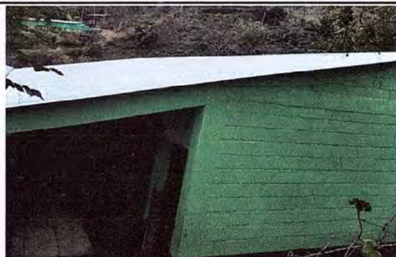
Foto 2: Entechado finalizado de la EORM Caserio Chioyal
