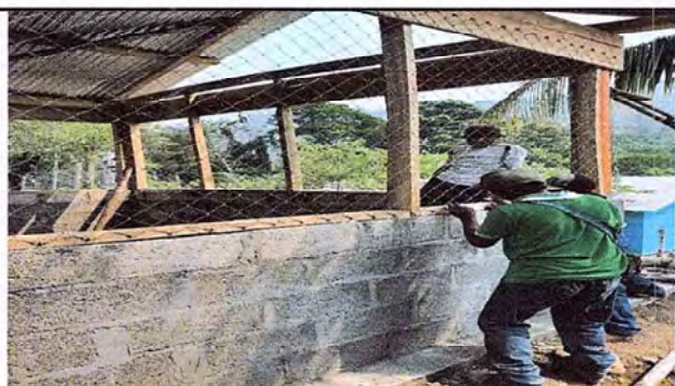
Foto 3: Circulación de la cocina con blocks y malla finalizado de la EORM Caserio Chioyal.
