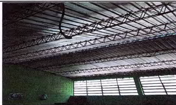
Foto 1: Terminación de entechado de la EORM Caserio Chioyal
